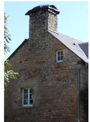
Détail de façade en pierre apparente
