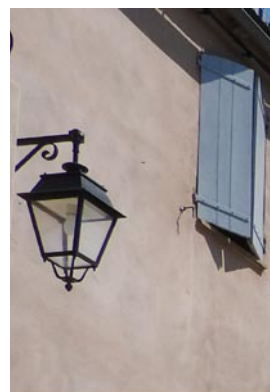
Détail de façade avec crépis
