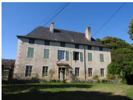
Devant une maison de maître, clôture composée d'un mur surmonté de grilles avec portail à piliers
