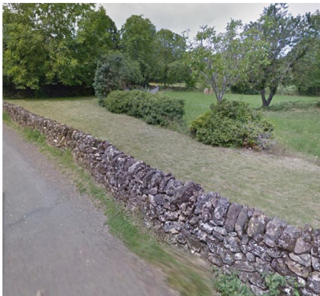
3.2.17 Muret de type 1
