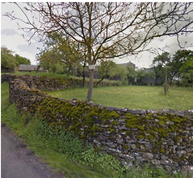
3.2.26 Muret de type 1
