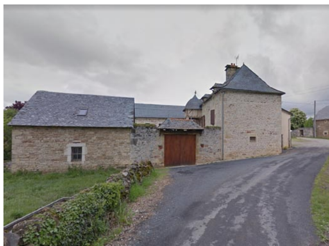
1.30 Château et Bâtiment de caractère
