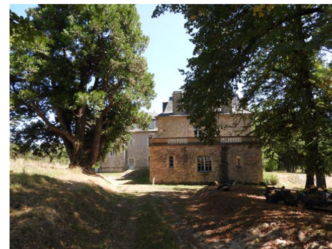
1.25 Château et bâtiment de caractère
