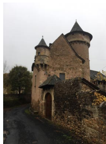
1.8 Château et bâtiment de caractère
