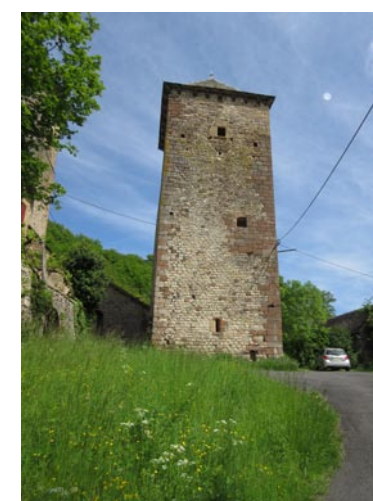
1.14 Château et bâtiment de caractère
