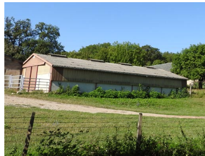
Bâti agricole récent
