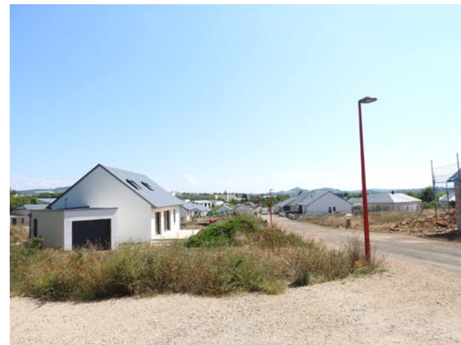
Lotissement à Bozouls
