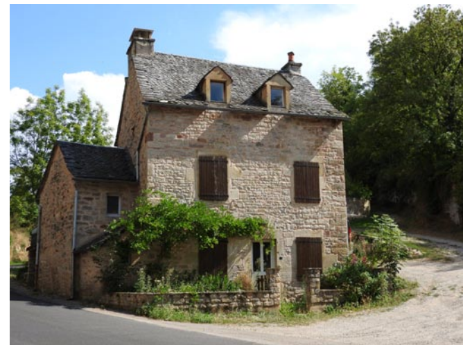
Façade de maison en calcaire
