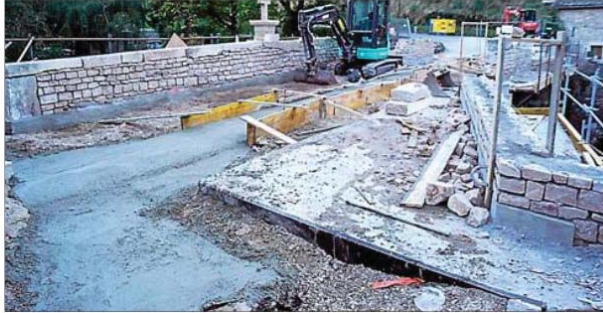
Le chantier du pont avance comme prévu.
