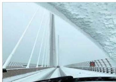
Circulation ralentie sur le viaduc de Millau.
