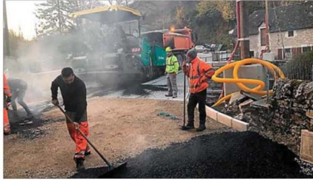
Pose de l'enrobé sur le pont élargi.
