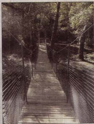
L'une des quatre passerelles installées pour enjamber le canyon.
