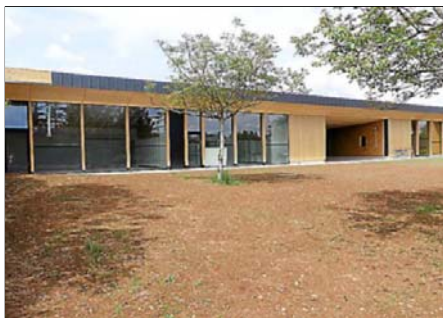
L'espace multiservices avec le centre de loisirs est en construction.
