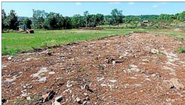
Le terrassement du lotissement route de la Gare est en cours d'achèvement.
