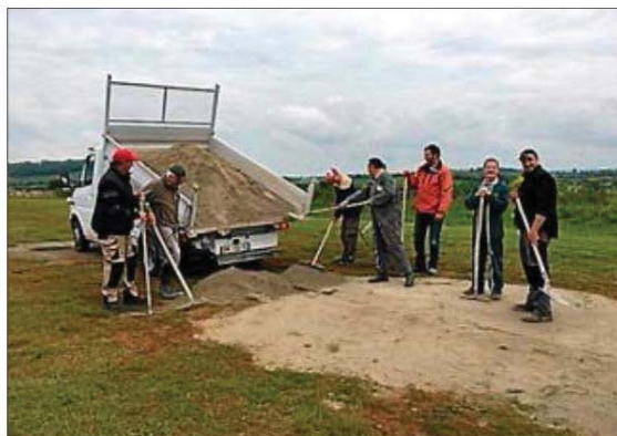
Vingt tonnes de sable répandu pour la réfection de la piste.
