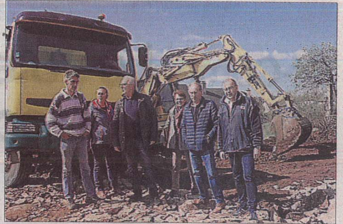
Les élus constatent l'avancée des travaux.
