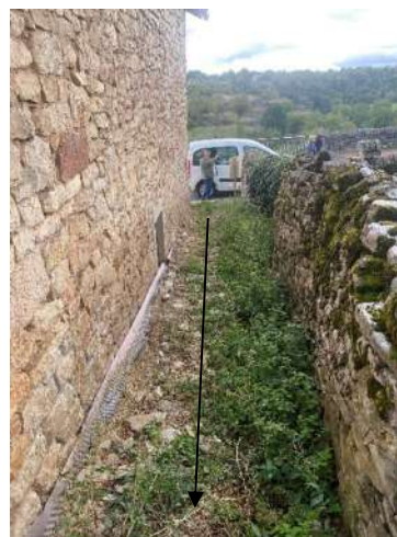
Entrée Côté Nord Est, du chemin rural faisant l'objet d'une demande d'aliénation
