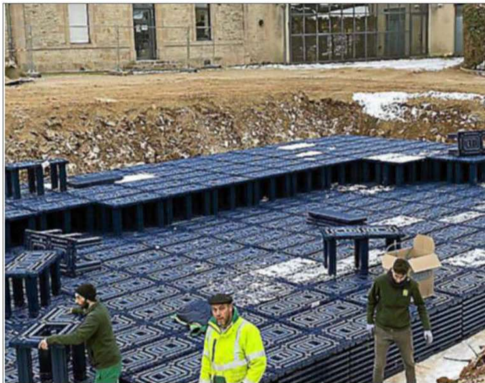
Le bassin puisard de la médiathèque en cours de réalisation, à l'aide de «légos» géants.
